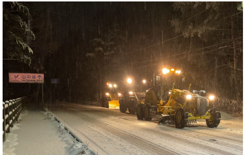
(令和6年2月29日 国道138号 山梨県山中湖村)
