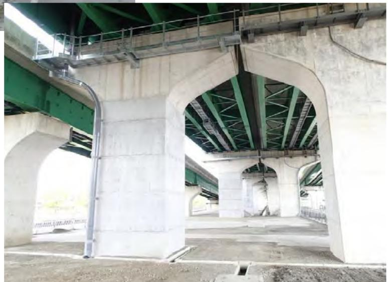
既設構造物の状況把握を適切に行い、コンクリートのひび割れ低減対策、締固め性能の向上、養生などにきめ細かな配慮を行いコンクリートの品質確保に努め、無事工事を完成させた。
