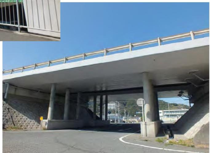
6ヶ所11橋と点在する作業であり、狭隘な桁下空間での断面補修では品質確保のための夜間通行止めを提案、不慣れな工法では作業員を含めた技術講習を行うことにより良好な品質・出来形を確保するとともに施工管理及び出来映えについても良好な工事であった。
