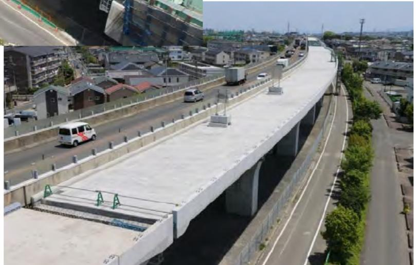
コンクリートの配合検討、円筒型型枠下面への充填確認等、コンクリートの品質管理について創意工夫を行った。また、近接工事調整や地元住民への配慮を適切に実施し、工程管理、安全対策に努力して無事故で工事を完成させた。
