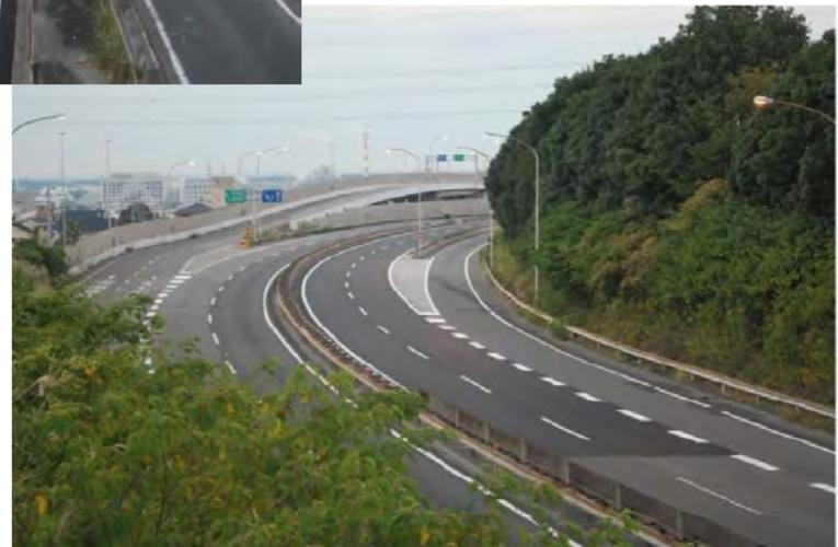
夏季の自動車専用道路の工事において、基層・表層に高締固め型フィニッシャを使用、交通開放温度を40度以下に設定するなどの提案を行い平坦性向上に努めた。また、合流部の交通規制の形態、施工区間割りなど現地条件を踏まえ施工管理、工程管理を行った。
