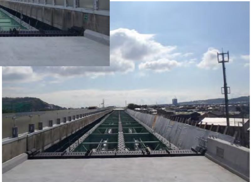
近接工事や交通量の多い現道を規制しての夜間架設工事であったが、騒音の低減、ビラ配布による交通規制周知を確実に行いトラブル無く工事を完成させた。また、高所での足場組立作業の低減、二重監視センサーの設置による安全対策に努めた。
