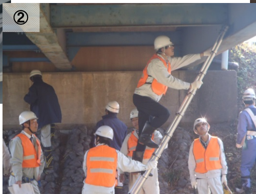
③コンクリート橋桁の打音調査 市道 向山線 ハンマーによる打音調査で コンクリートの浮きや剥離の有無を確認
