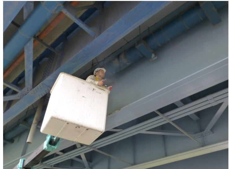
高所作業車による近接目視
