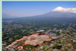
新東名開通後 契約が好調の富士山フロント工業団地(富士市)
