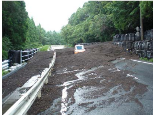
7月14日 土砂撤去作業の状況
