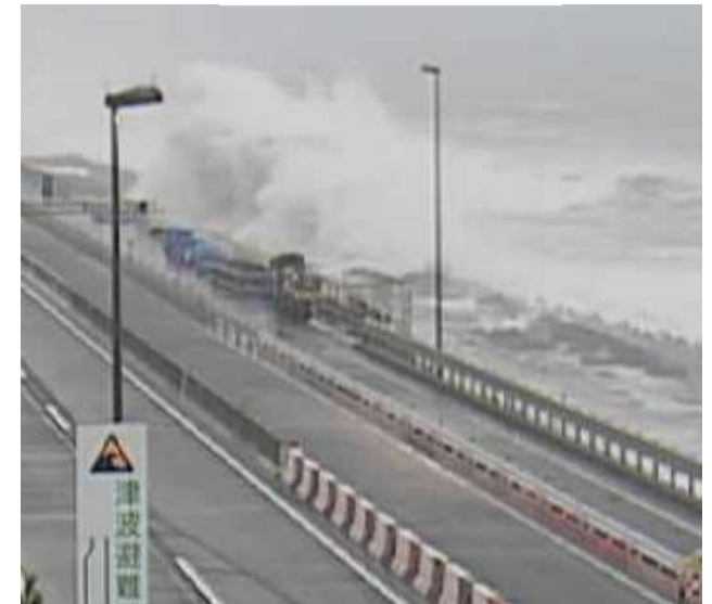
令和元年9月 神奈川県大磯町 国道1号
