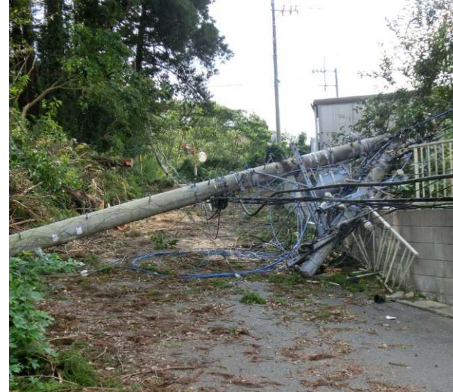
令和元年9月 千葉県山武市 山武市道
