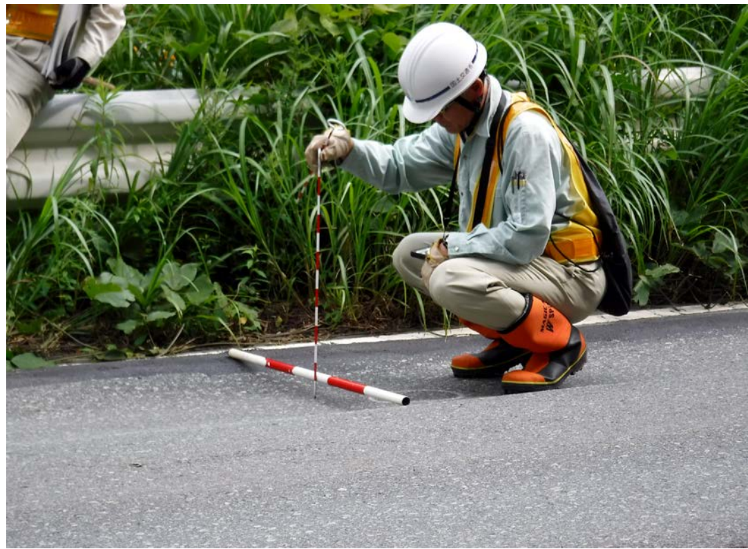
路面の亀裂等の確認中
