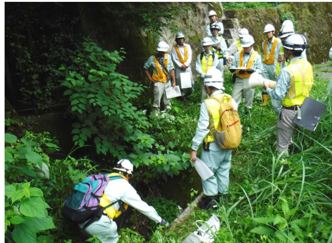
排水工の土砂堆積状況の確認中
