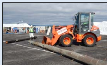
島田建設業協会が 倒壊電柱を撤去
