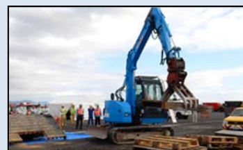
解体工事業協会による 倒壊ガレキの撤去
