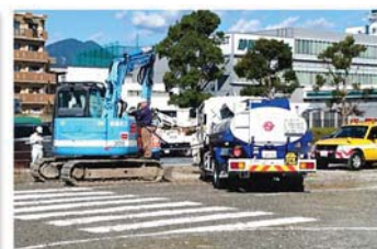
石油業と連携した重機への給油
