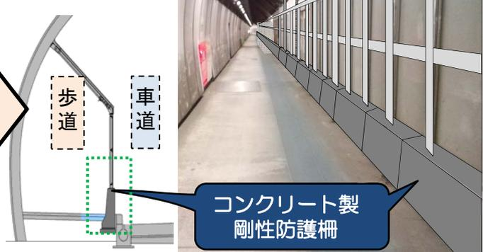
通行車両が仕切壁に衝突しても、歩行者や自転車が巻き込まれないようにコンクリート製の防護柵に変更します。
