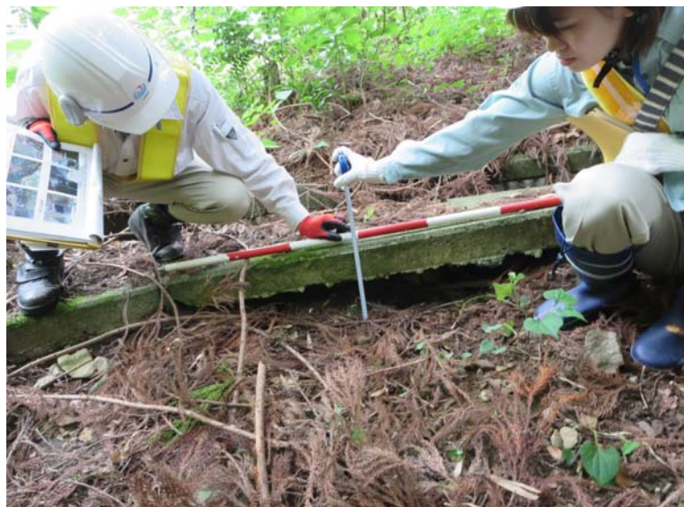
縦排水溝脇のコンクリートの段差を測定
