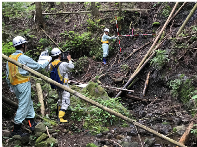
水路脇にある流路部の土砂堆積状況を確認
