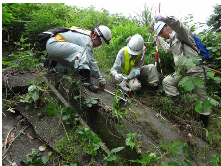
盛土斜面の縦排水溝脇のコンクリートの段差を測定
