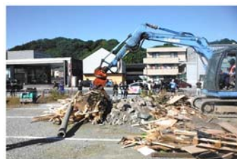
建設業、レンタル、解体業が連携した重機の手配とガレキの撤去
