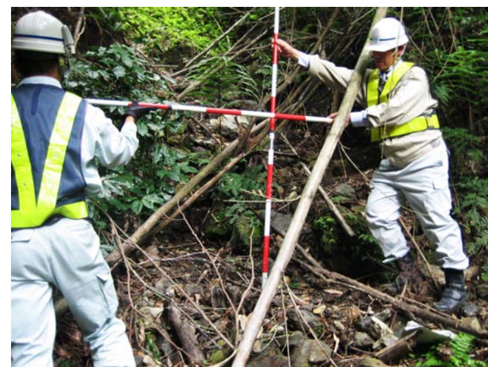
法面崩壊地形の状況変化を確認
