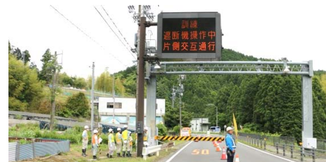
道路情報板を操作し、道路利用者に通行規制を周知。
