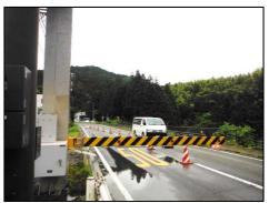
機側盤を操作し、遮断機を操作しています。
