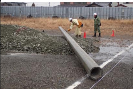
倒壊電柱の安全確認（中部電力）
