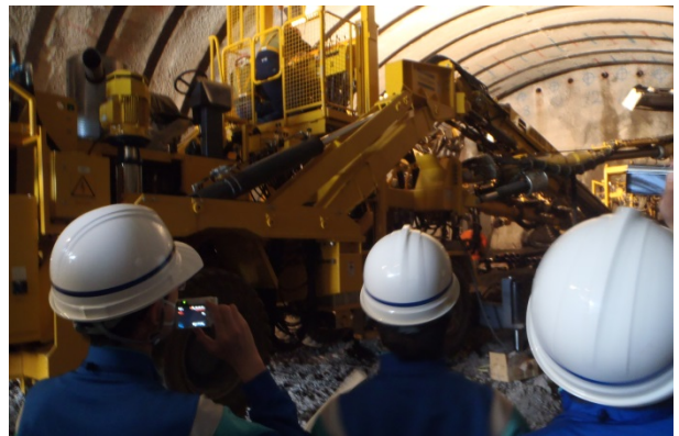
丸子藁科トンネル工事現場を見学
