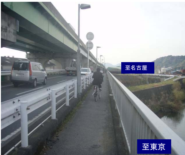
現況 歩道幅が狭くすれ違うのが困難 (写真1)
