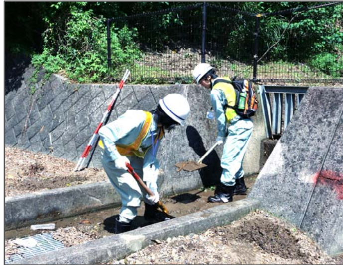
②集水柵土砂撤去
