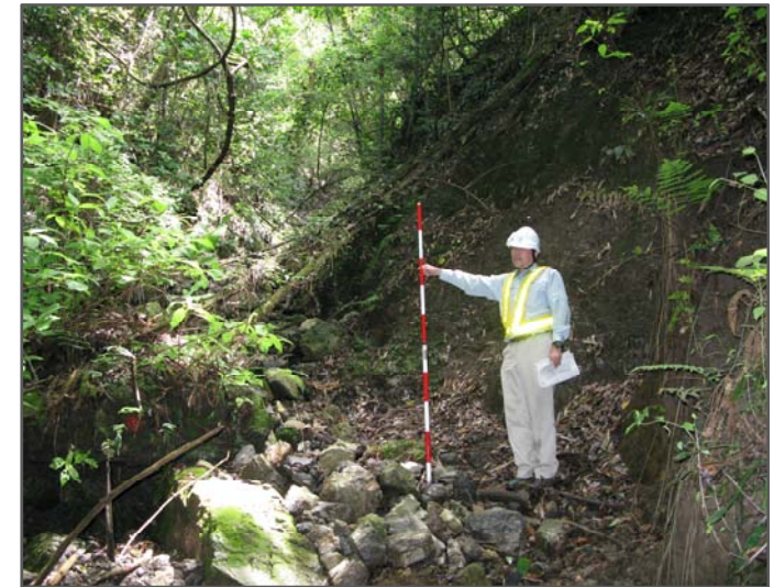
③土砂状況確認
