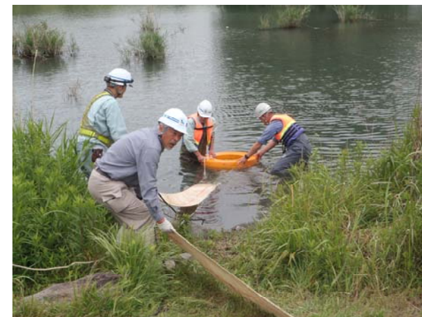
③排水ポンプの設置
