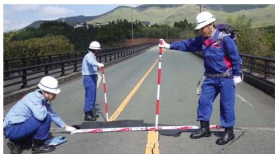
大切畑大橋被災状況調査その1
