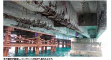
中の鋼材が腐食し、コンクリートが剥がれ落ちる場合がある
