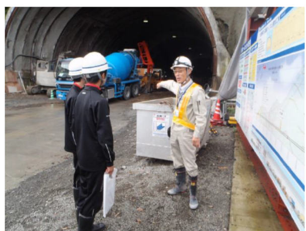
トンネル工事現場を見学
