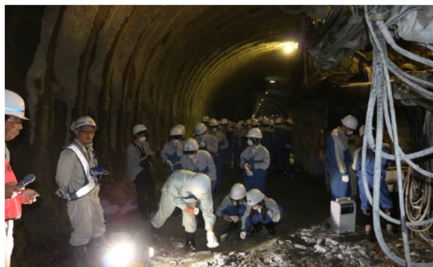
★2万年前の岩石と重機を見て、トンネル工事に さらに興味を持たれた様です。
