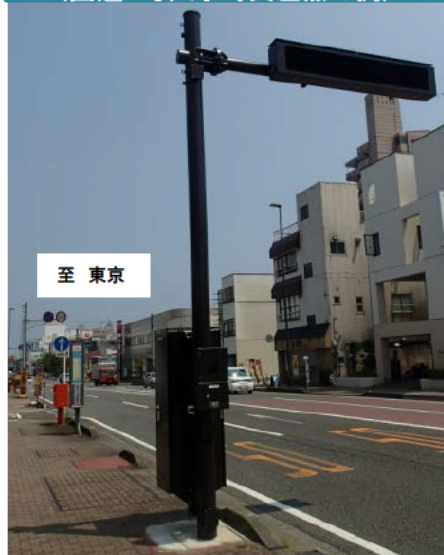
津波情報板外観 (国道1号大手町交差点の例)
