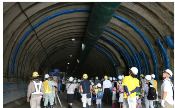
トンネルの工法の説明を受けています
