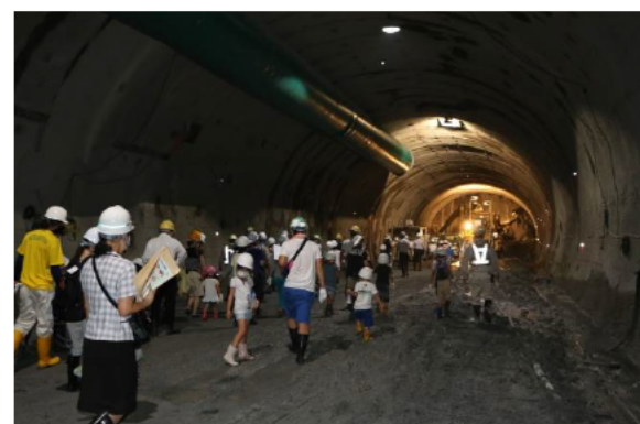
間近で切羽（掘削箇所）を見ました
