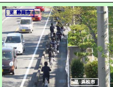
国道1号 水守地区歩道設置
