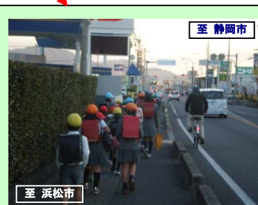
国道1号 青島地区歩道設置
