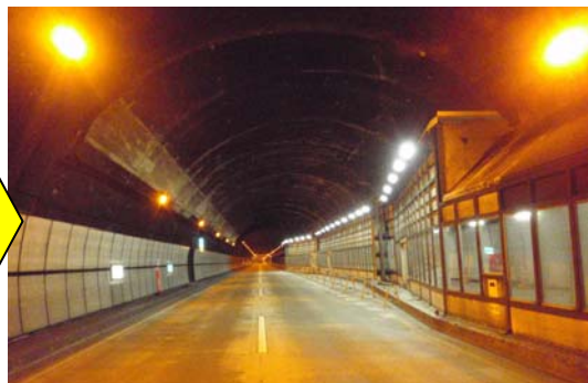
(天井板撤去後)
