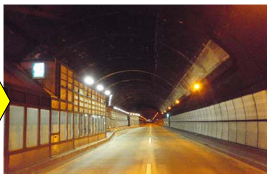
(天井板撤去後)
