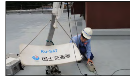
可搬式衛星通信装置の設置
