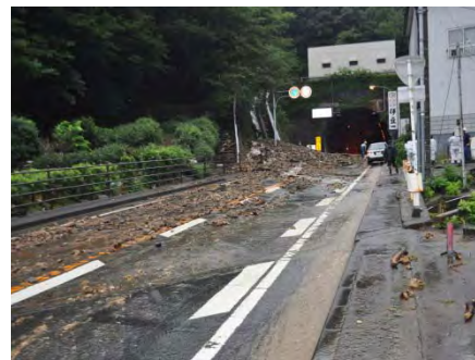
国道136号での土砂流出 宇久須地区
