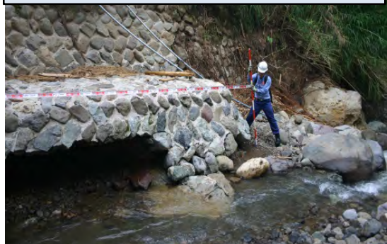
(調査状況：浜川流域②)
