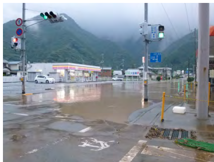
国道136号での浸水被害 宇久須地区
