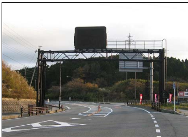
(通行止め装置)
