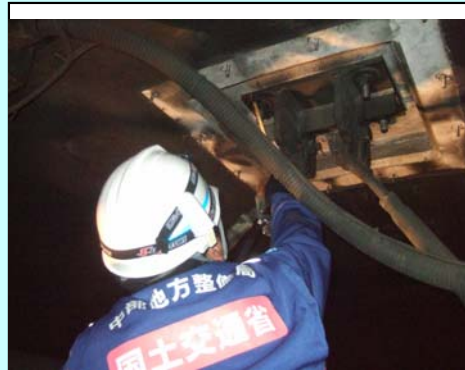
天井に設置されているジェットファンの取付状況の確認。
