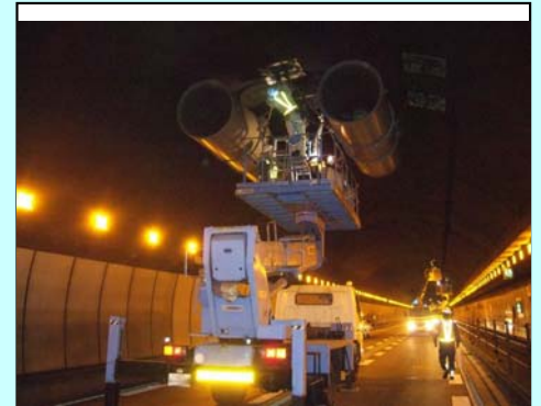
全面通行止とし、作業員・車両の安全を確保して作業実施。
