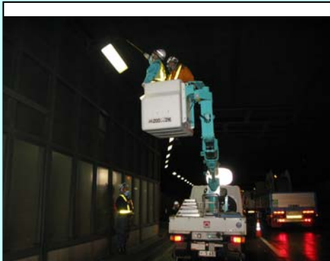
天井板の点検状況。
