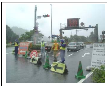
【雨量規制区間の通行規制により二次災害を防ぐ】
