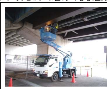
【定期点検により橋梁をきめ細やかに管理】
