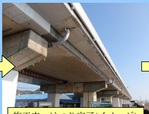
施工中：はつり完了(イメージ)
