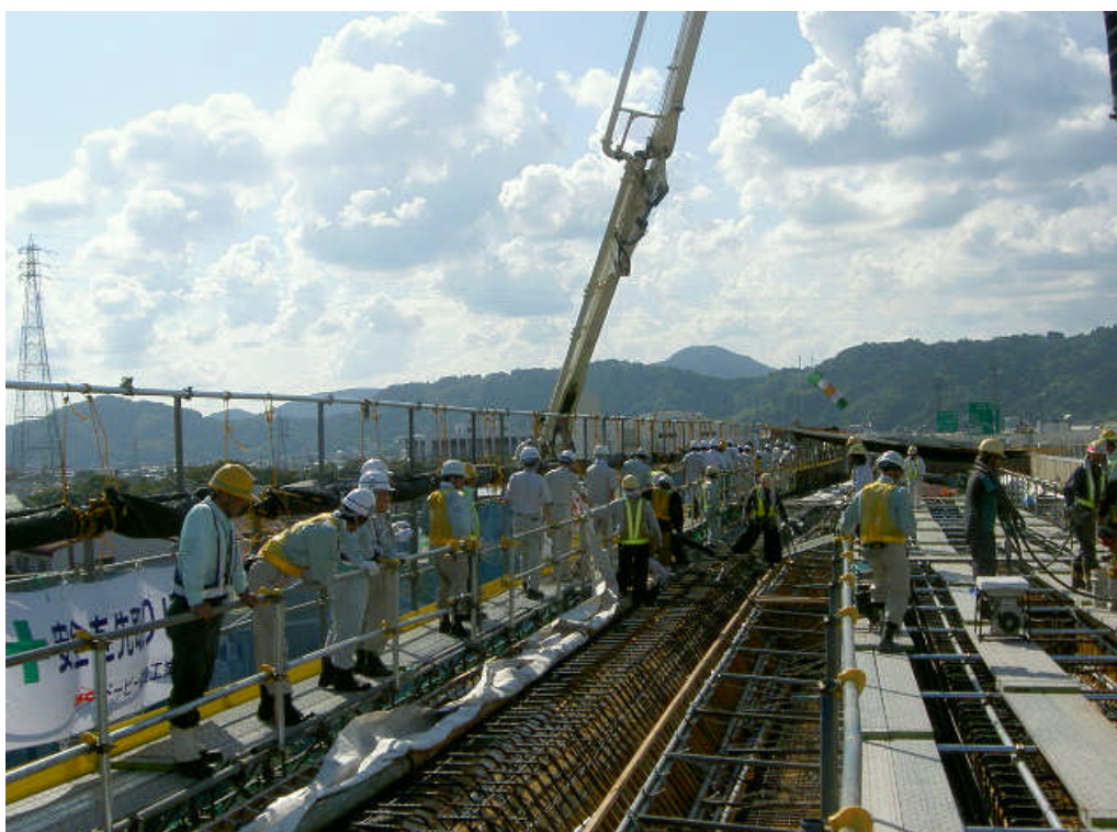
現場での研修状況
