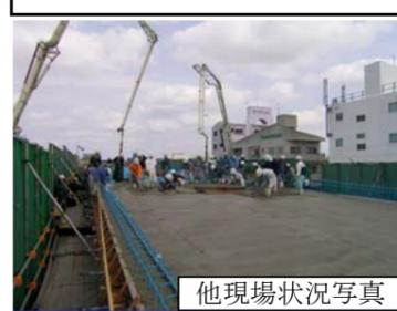
コンクリートをポンプ車を使用して打設する。
