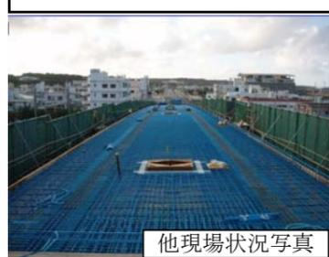
型枠内に鉄筋を組み立てる。
