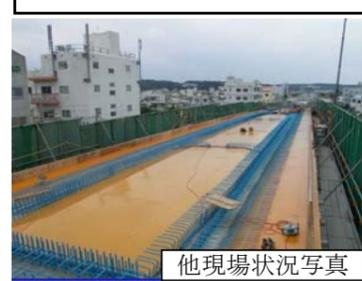
床版部分の型枠を組立・固定する。
