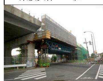
P212～P213間は楔支柱式支保工、P213～P214間は大型トラス及び大型支柱式支保工で組立てる。
