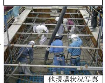
コンクリートポンプ車にて生コンをウェブ→下床版の順で打設する。
