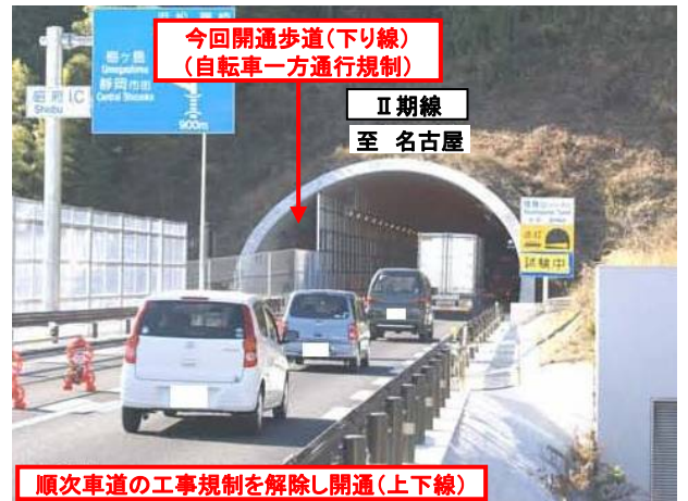
② 賤機山トンネル(唐瀬IC方向から昭府IC方向を望む)
