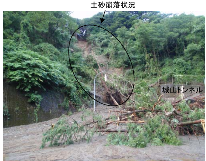
国道246号より城山トンネルを望む
