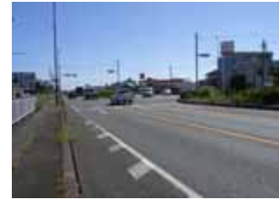
国道1号北東側から交差点を臨む
