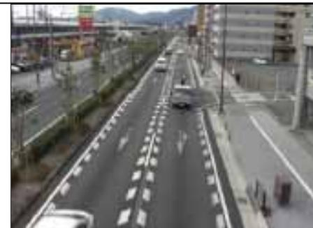
車線の形状に沿って、減速帯(ドットライン)を設置し幅員を狭く見せることにより、速度抑制及び注意喚起を図ります。
