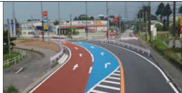
視覚的にわかりやすい路面舗装の色の変化により、心理的な注意意識を高め、交差点直近での速度抑制や注意喚起及び走行軌跡の安定を図ります。
