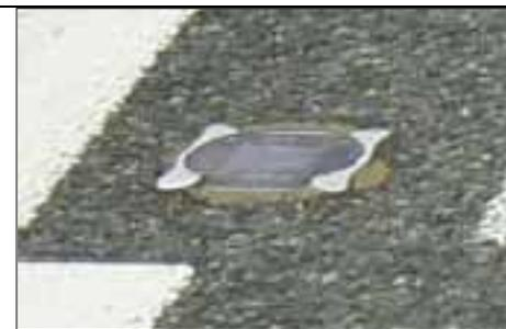
車道中央線に自発光鉄を設置し、夜間の中央線の位置を明確にします。
