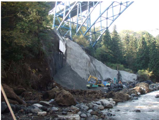
須川橋橋脚前面 浸食される恐れがある箇所の復旧状況
