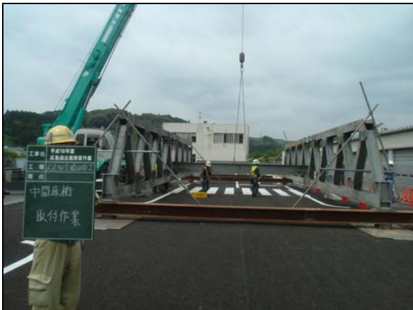
中間横桁 架設
