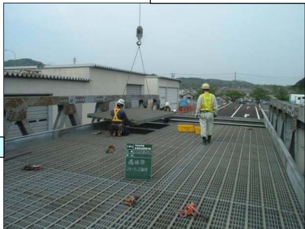
グレーチング 取り付け
