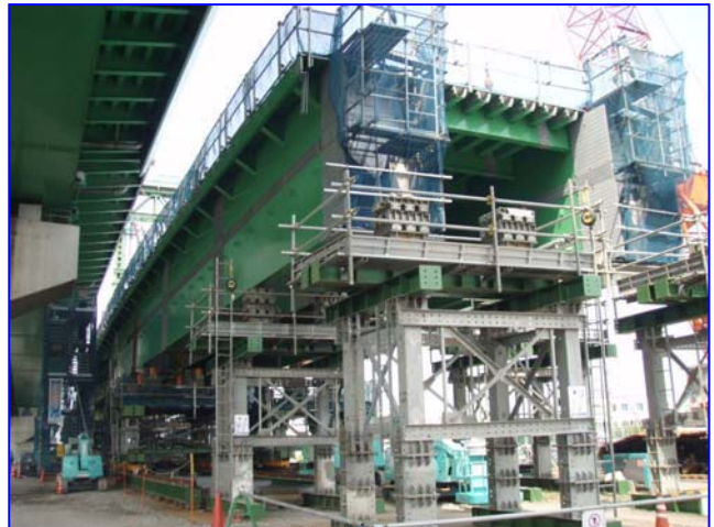
西側（名古屋側）から望む 従走台車（水平ジャッキ）及び地組架台
