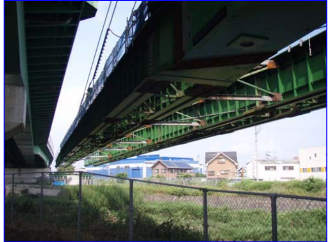
西側（名古屋側）から望む 従走台車（水平ジャッキ）及び地組架台
