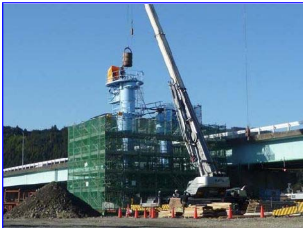
橋梁下部工【P3橋脚】(左岸下流から)
