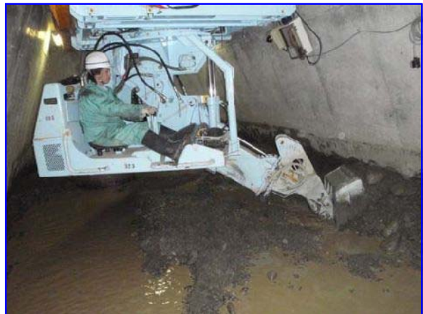
ケーソン基礎作業室内【掘削状況】
