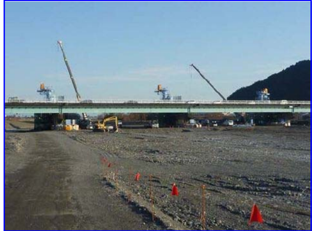
橋梁下部工【全景】(上流から)
