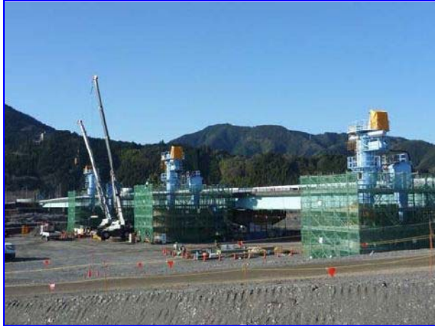
橋梁下部工【全景】(左岸下流から)
