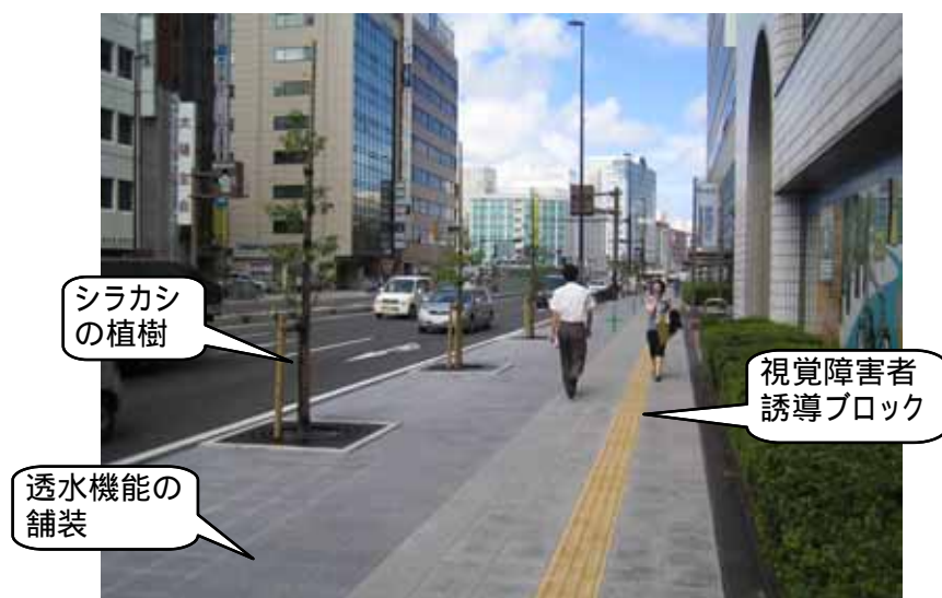
写真1 歩道整備状況(透水機能のある舗装、シンプルなデザイン、視覚障害者誘導ブロックの設置、シラカシの植樹)
