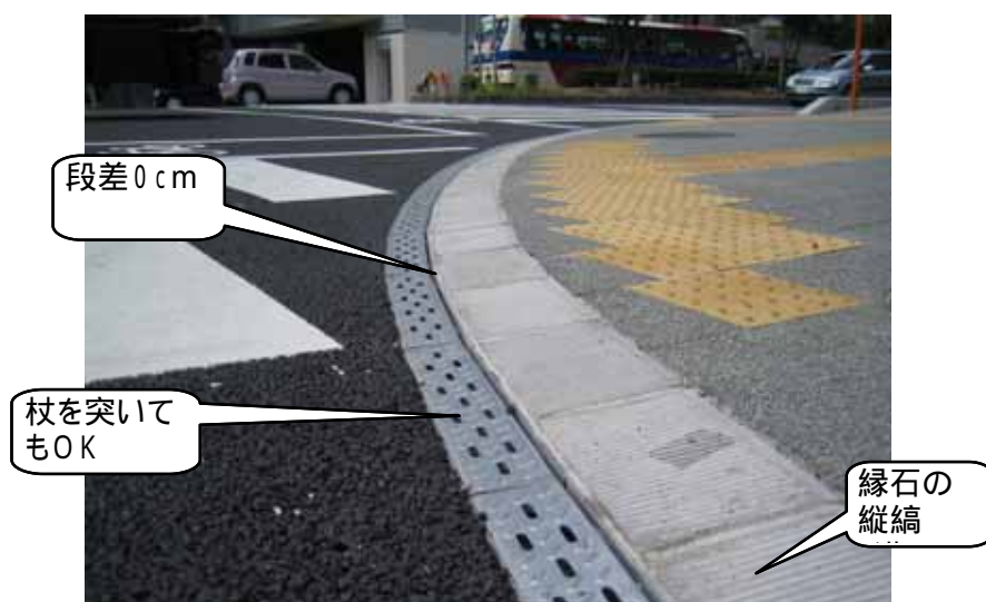
写真2 車道と歩道の段差を解消。排水蓋は杖がはまらない大きさの穴。縁石の縦縞は白杖での認識性が高い。
