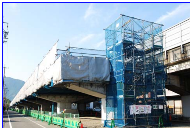
北側(東京側) 見学入口(P3昇降階段付近)
