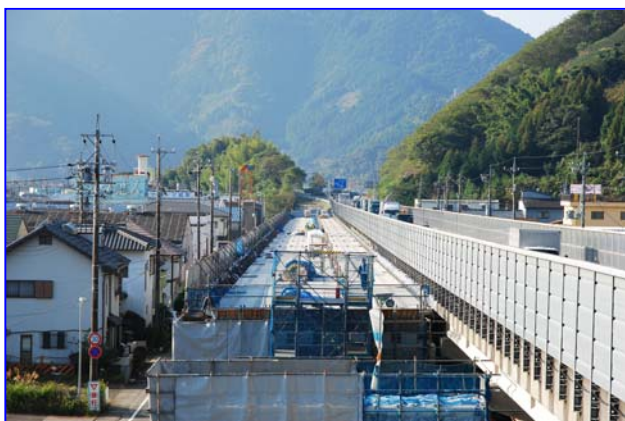
北側(東京側) 橋面上(P3橋脚より)
