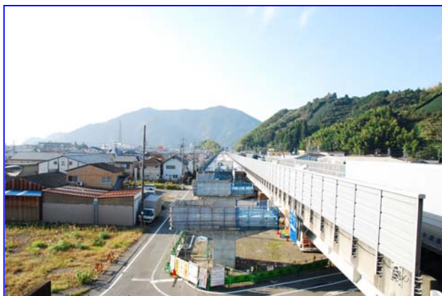
北側(東京側) 現場全景(A1橋台より)
