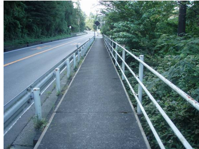
歩道表面の状況
