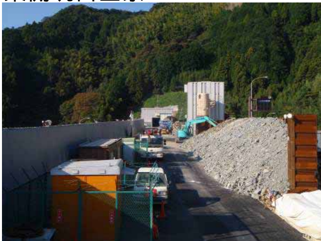
東側坑口全景
