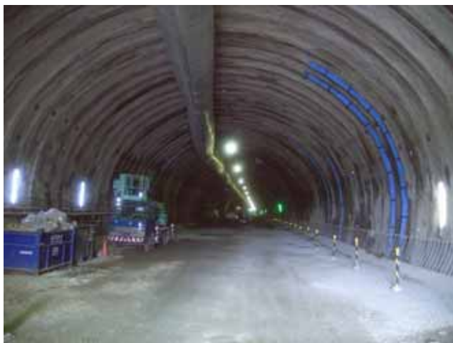
東側坑口付近
