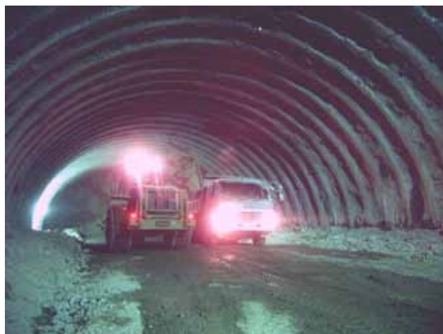
トンネル坑内作業状況
