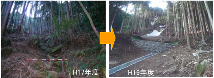
擁壁工+落石防護柵工完了
