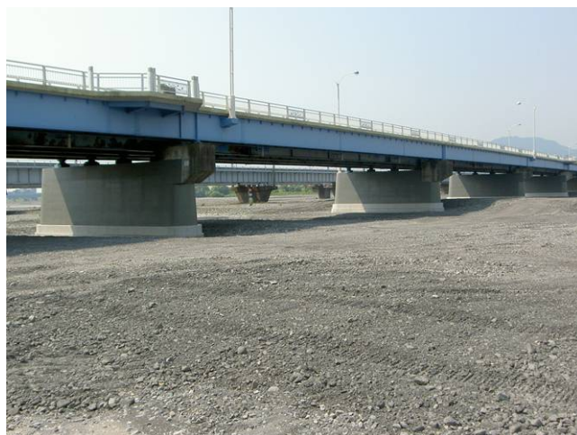
第2回実地研修橋梁 (国道1号 駿河大橋)
