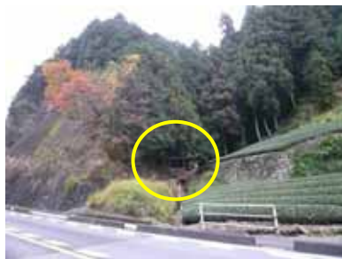
パトロール予定箇所 （国道52号 清水区小河内の溪流）
